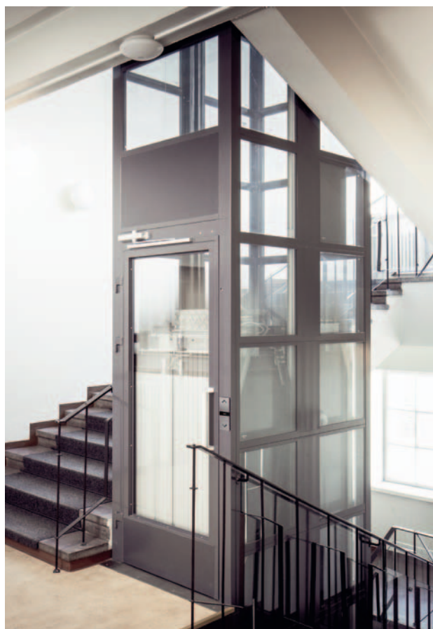
Sjaket til KONE ProSpace er selvbærende og påvirker dermed ikke veggene i bygningen.
